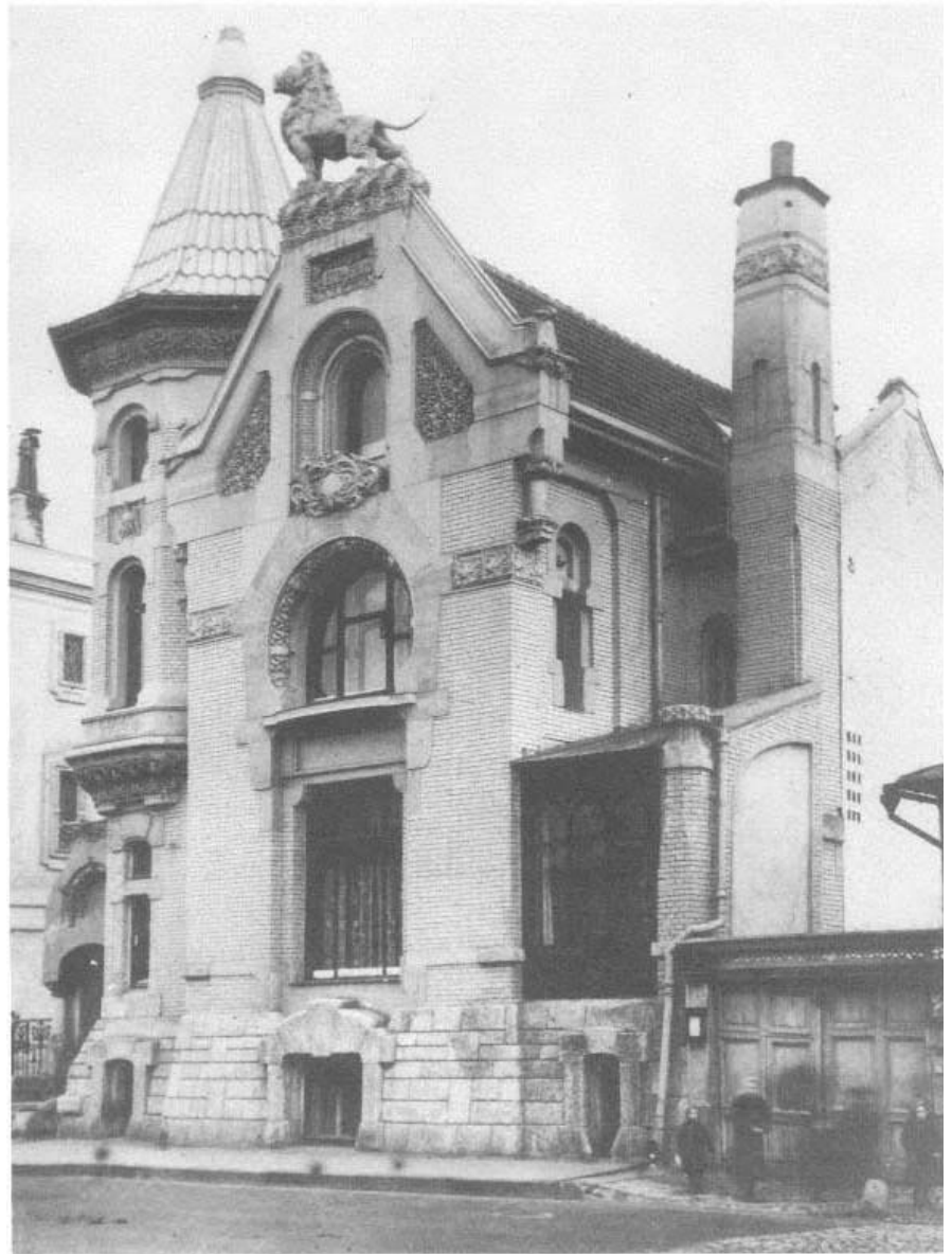
Л.Н. Кекушев. Дом Кекушева на Остоженке 21, 1901
