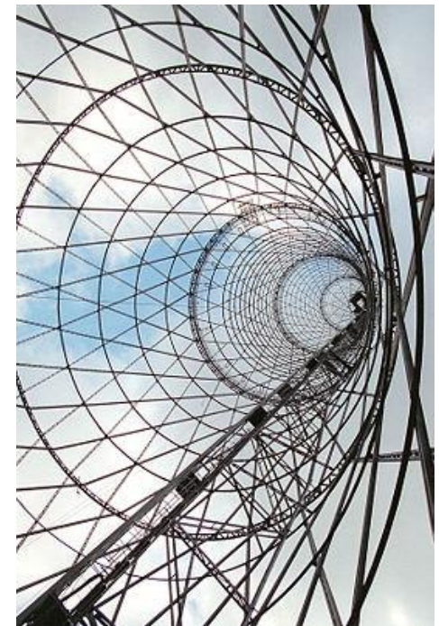
Вид башни изнутри
