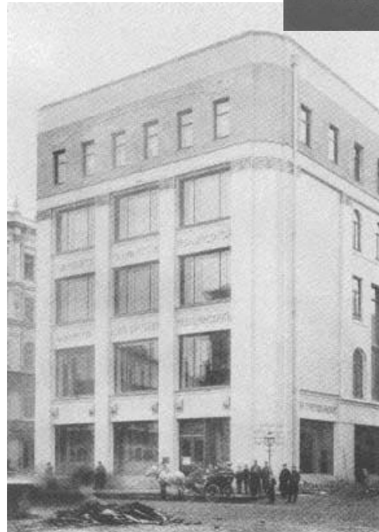
Шехтель. Банк Рябушинских, на Биржевой площади, 1903
