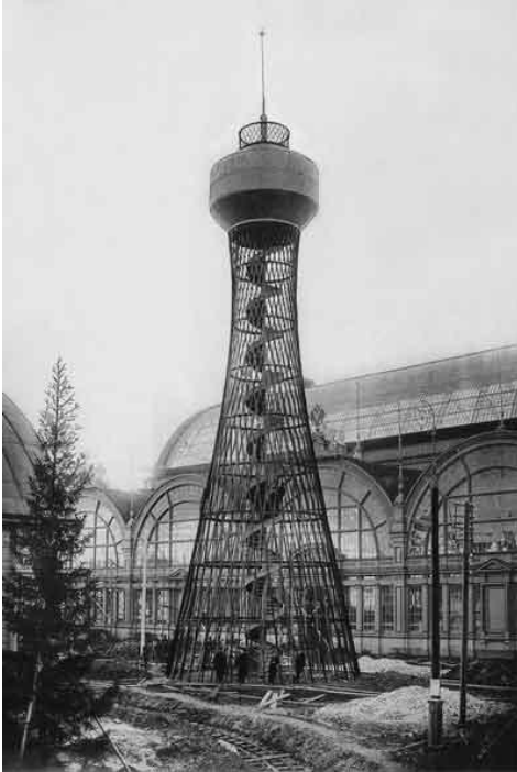
Гиперболоидная сетчатая водонапорная башня системы Шухова, построенная на XVI Всероссийской художественно-промышленной выставке в Нижнем Новгороде
