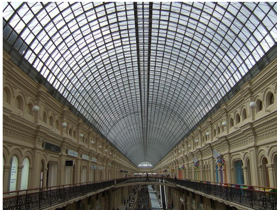
В.Г.Шухов. Конструкции арочных покрытий московских магазинов ГУМ
