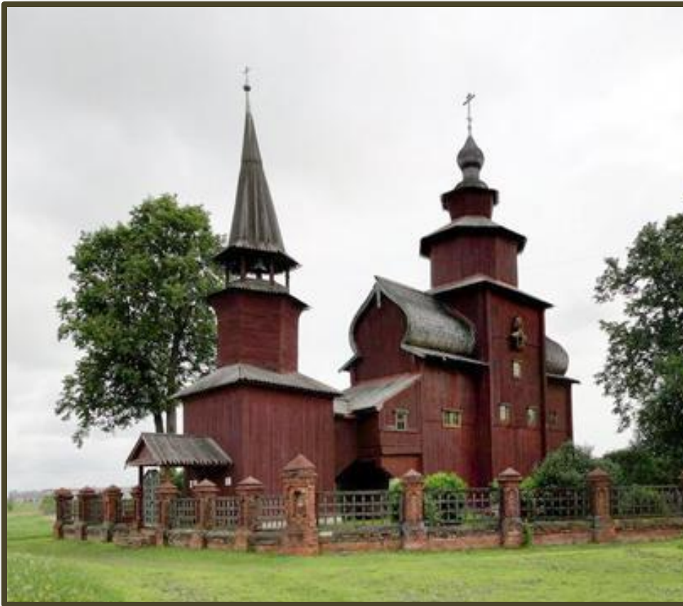
Церковь Иоанна Богослова в селе Богослов Ярославской области
