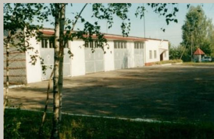
Пожарная часть. 2011 год. ул. Понятовская.
