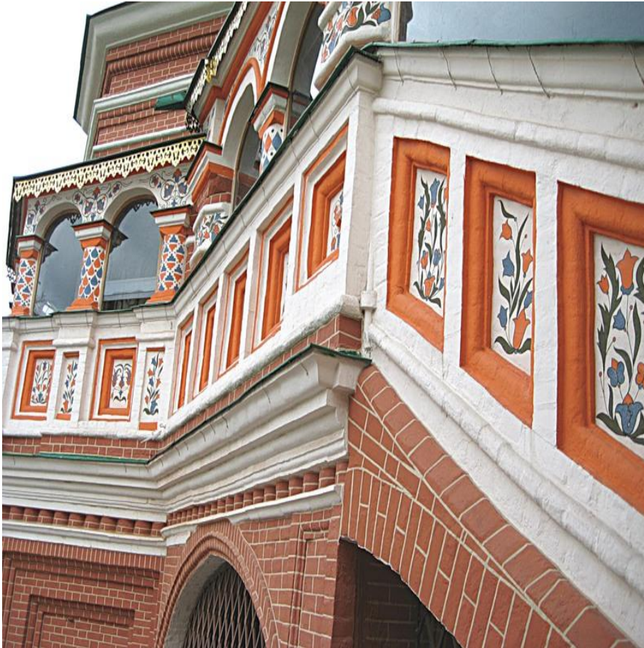
Галереи и крыльца
