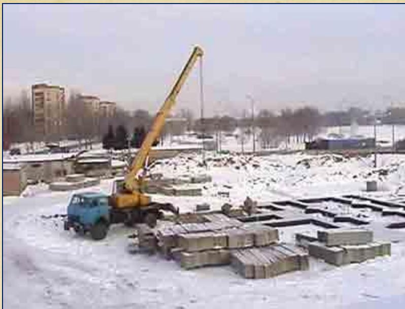
Февраль 2005 установка бетонных фундаментных блоков
