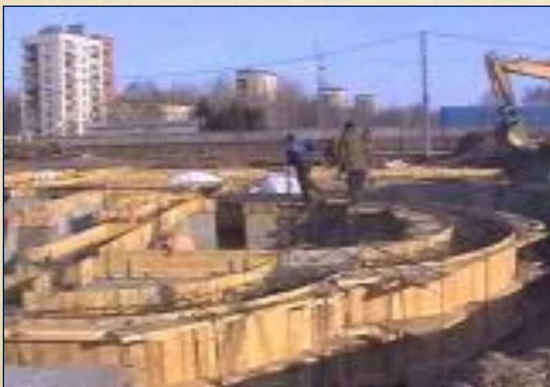
Февраль 2005 установка бетонных фундаментных блоков
