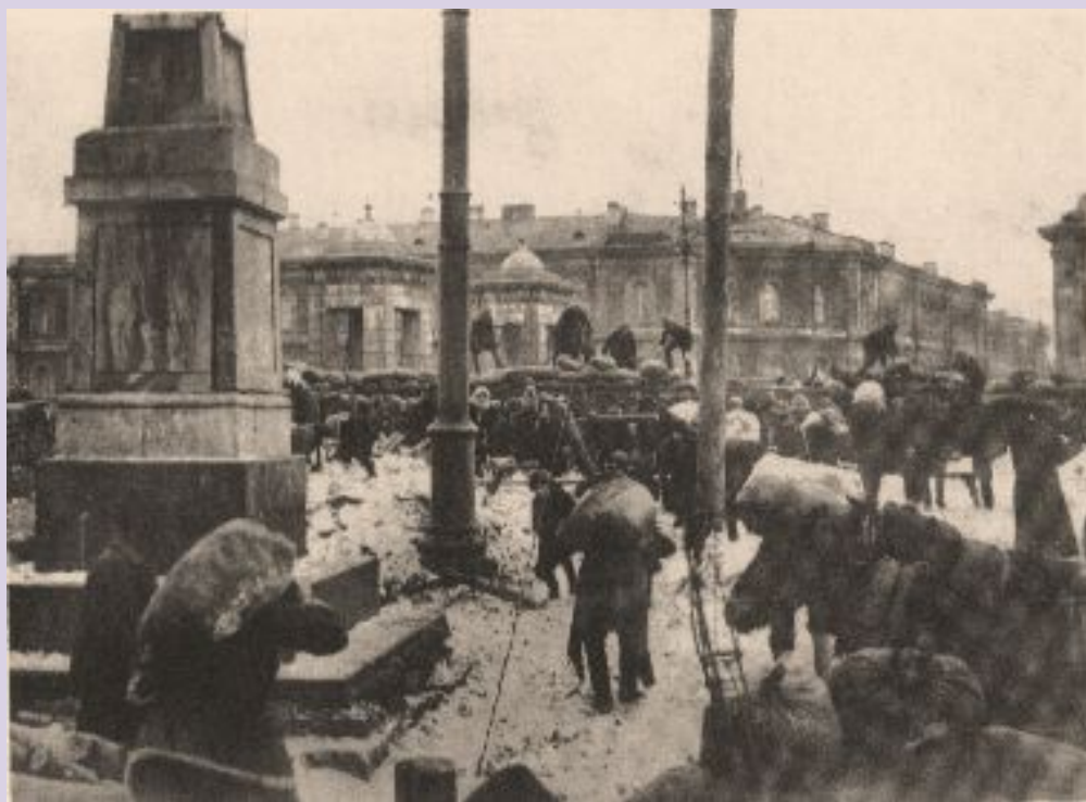
Строительство баррикад в Петрограде
