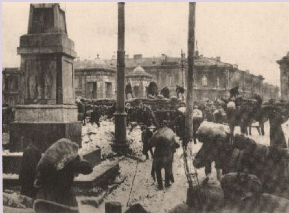
Строительство баррикад в Петрограде
