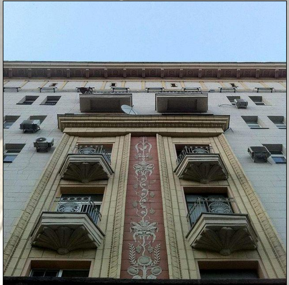
Мордвинов А.Г. Жилой дом на Тверской улице в Москве (1938)
