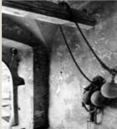
Противовесы на подъемнике ворот
