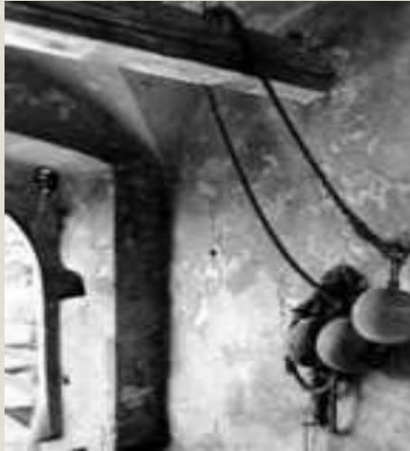
Противовесы на подъемнике ворот
