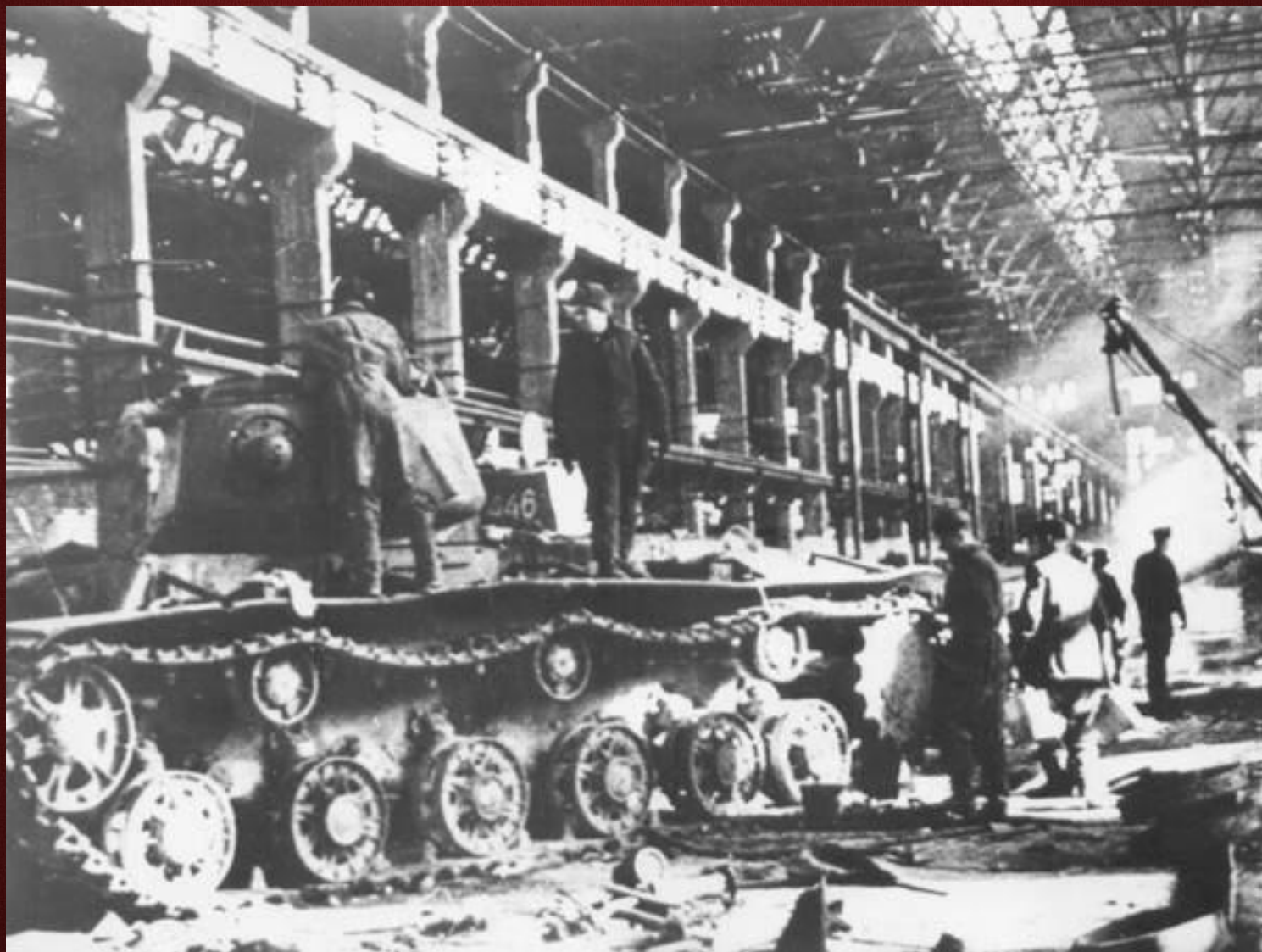
Ремонт боевой техники на Сталинградском тракторном заводе
