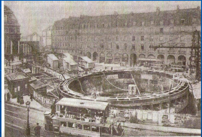
Франция. Париж. Строительство метро. 1906 г.
