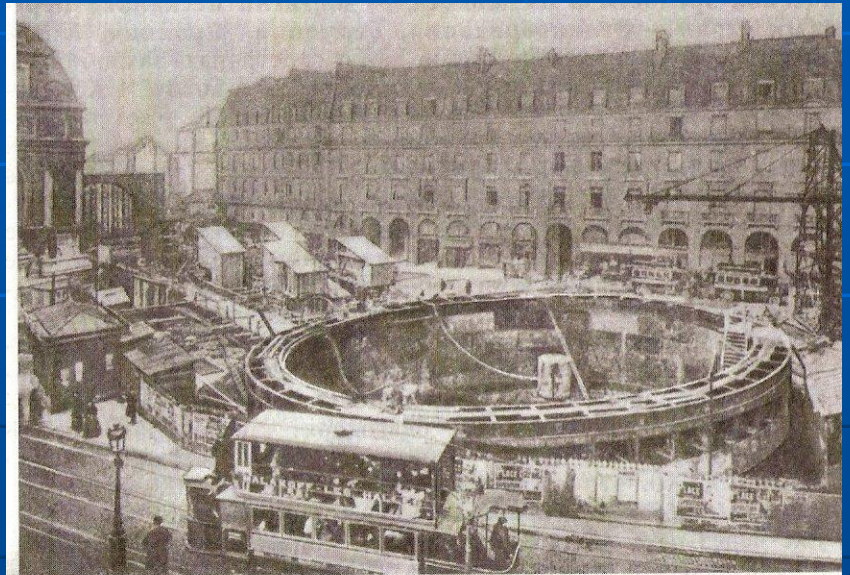
Франция. Париж. Строительство метро. 1906 г.
