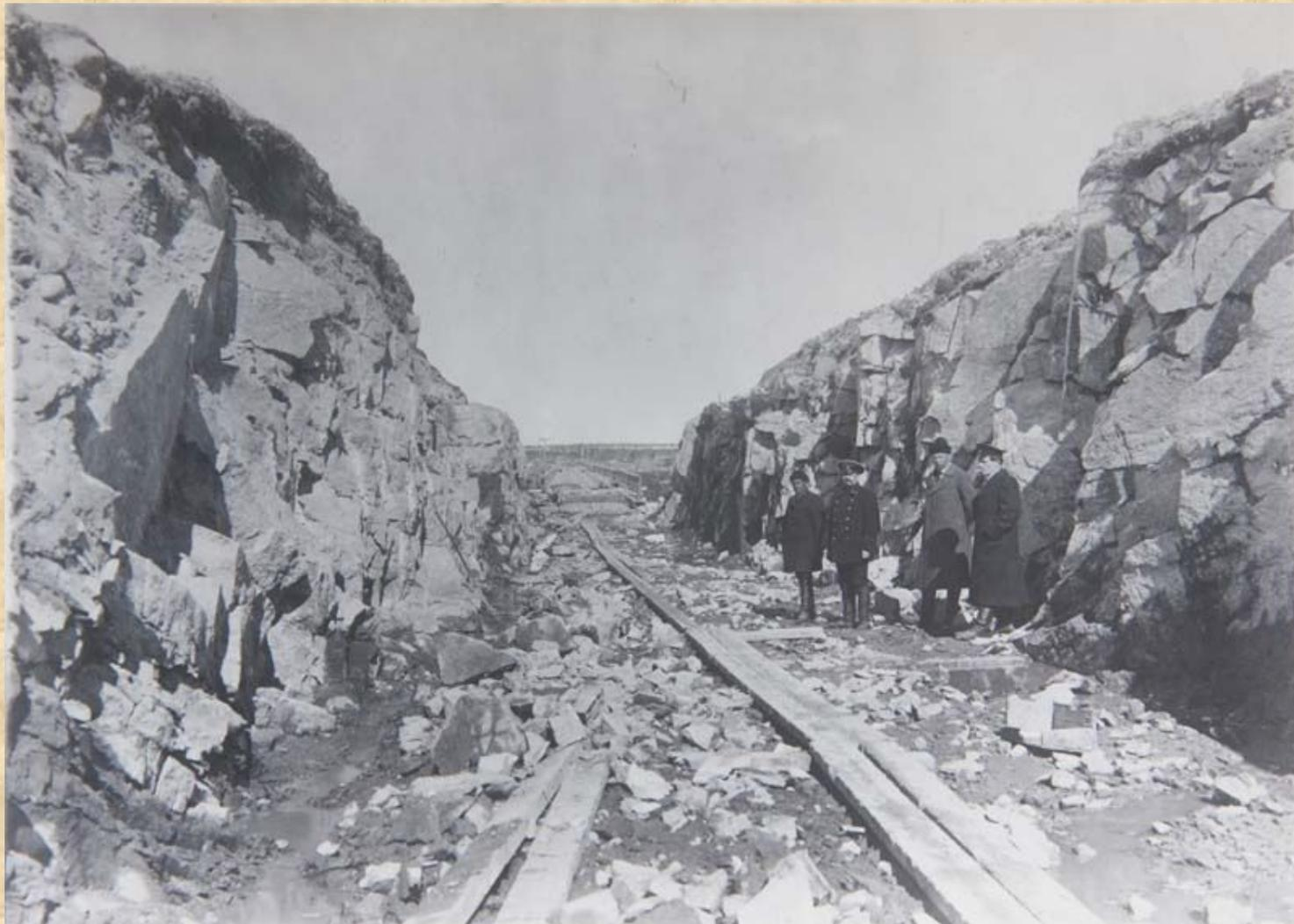
Рельсы на пути укладывали прямо на грунт, мосты строили деревянные. Не соблюдались технические нормы при устройстве полотна - подъемы доходили до 15 метров на километр пути (вместо допустимых 6 метров). Дорогу строили, так сказать, начерно. И все же 15 ноября 1916 года Мурманская железная дорога была сдана во временную эксплуатацию.
