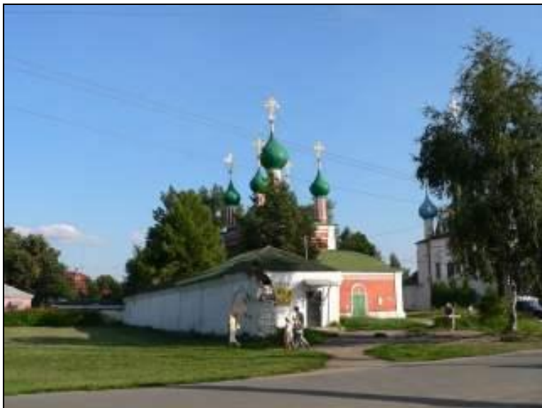
На Соборной площади Переславля-Залесского стоит церковь Александра Невского.
