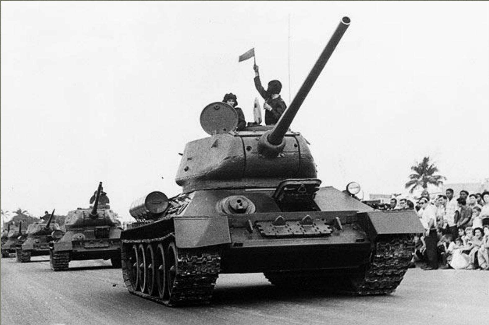
Уже в 1944 г. Т-34-85 применялся не только как танк, но и как транспортер пехоты. Поручни на корпусе позволяли пехотному «танковому десанту» передвигаться по полю боя на броне.
