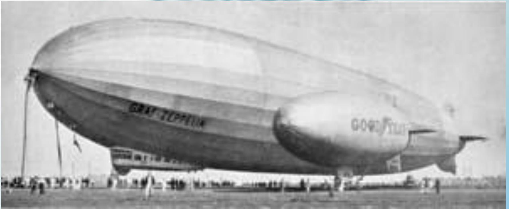
Длина 237 м, диаметр 30 м, 5 двигателей, скорость 135 км/час, грузоподъемность 60 т, объем оболочки 105.000 куб.м.
