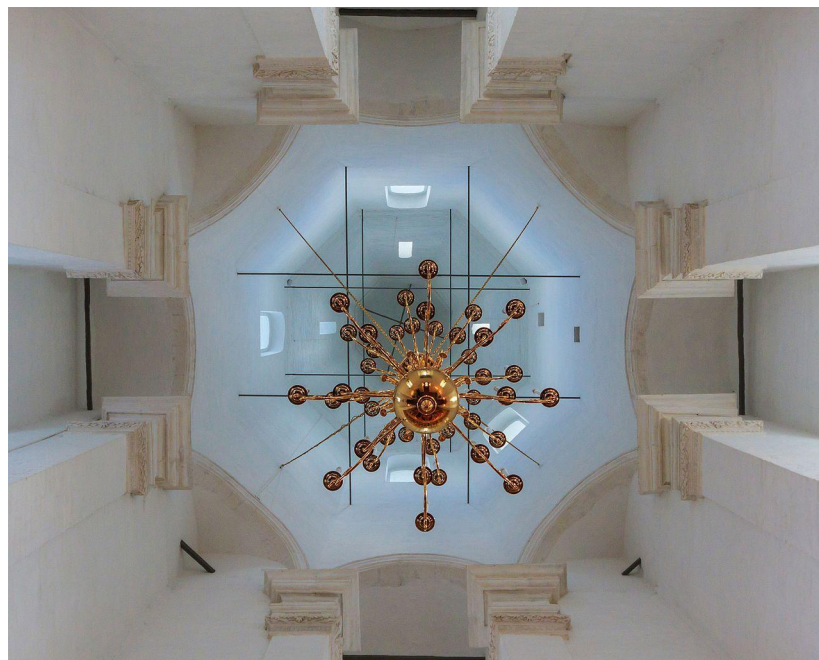
Внутренний вид шатрового свода
