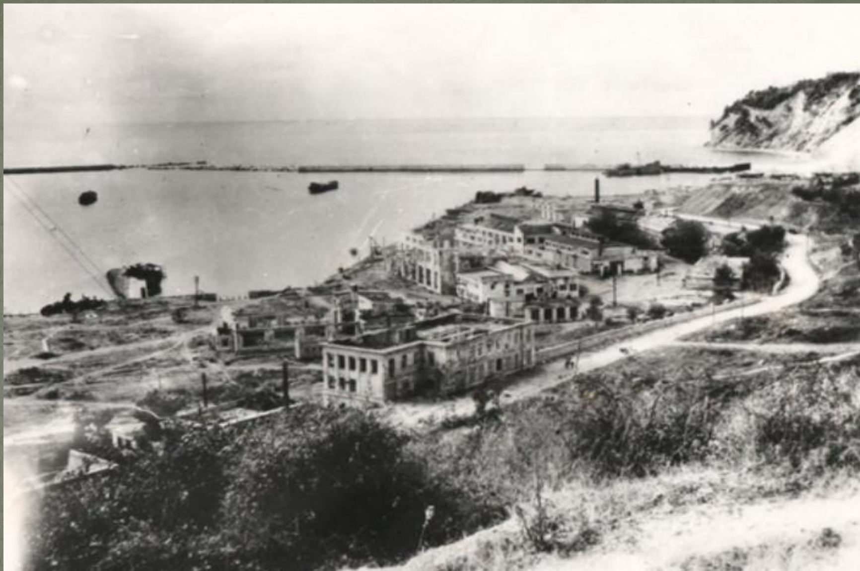
Разрушения в прибрежных районах Туапсе
