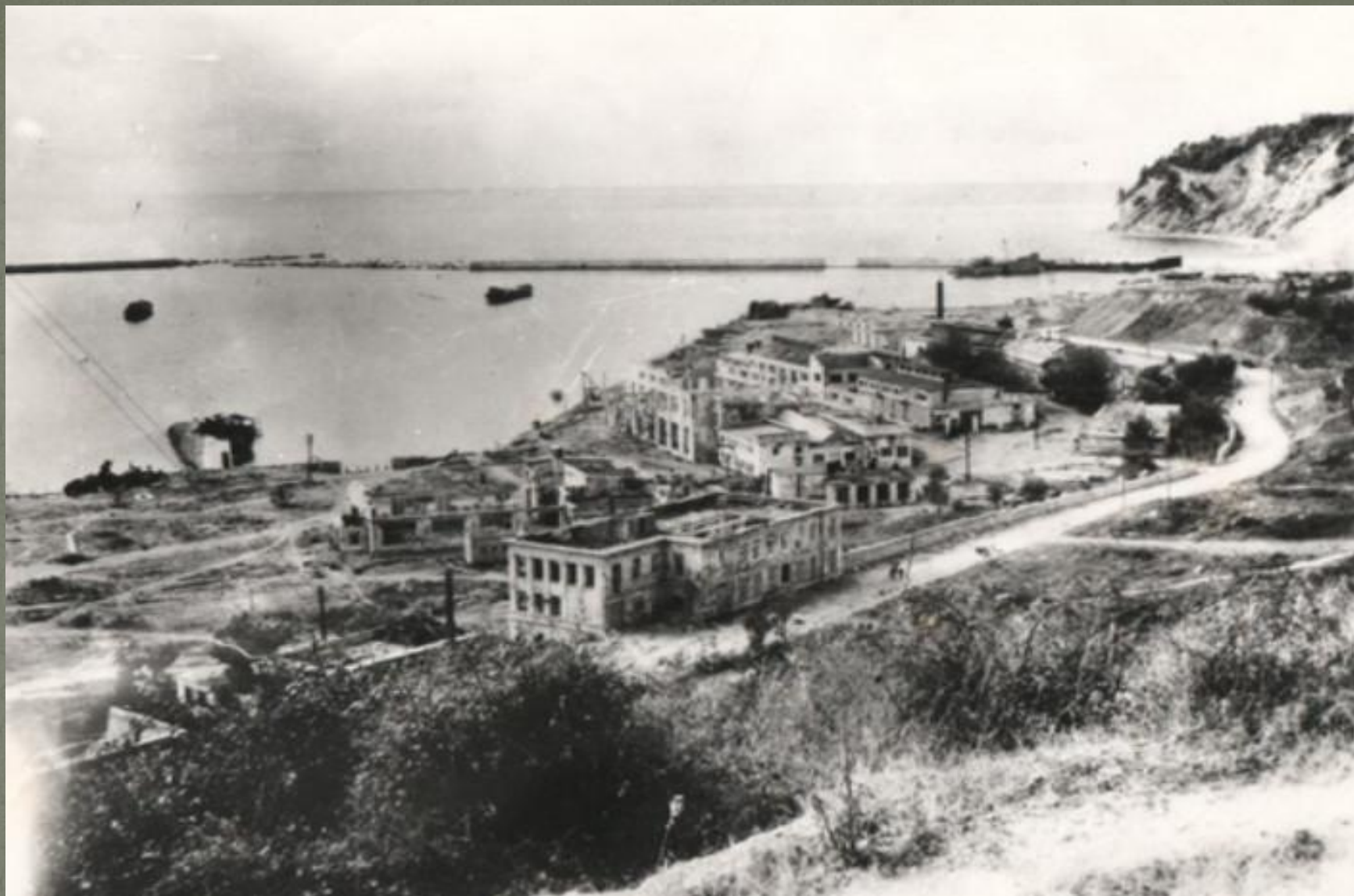
Разрушения в прибрежных районах Туапсе
