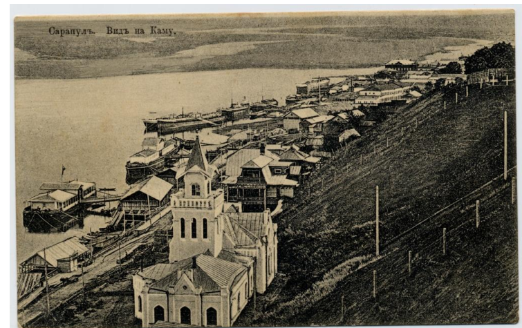
Водонасосная станция в Сарапуле. Архитектор Павел Алексеевич Трубников
