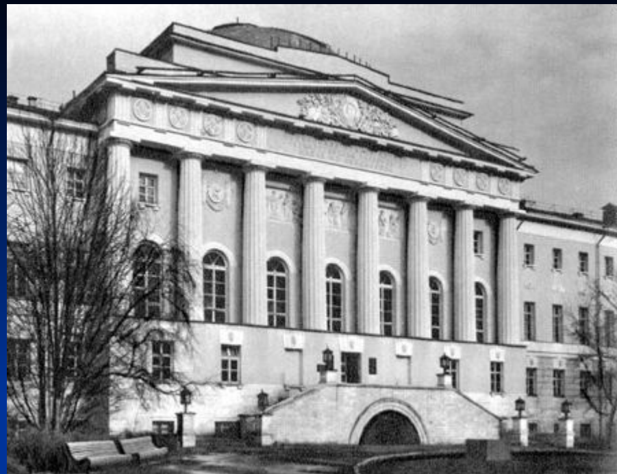
Старое здание Московского университета на Моховой, где учился и работал В.О. Ключевский.
