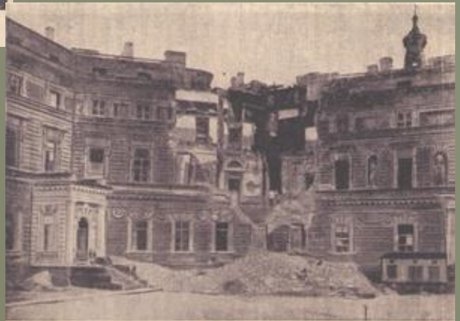
Нижнегородский завод, разрушенный 4 апреля 1942 г. фугасной бомбой
