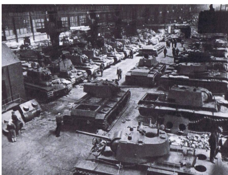
Сборка танков КВ в цехе Кировского завода
