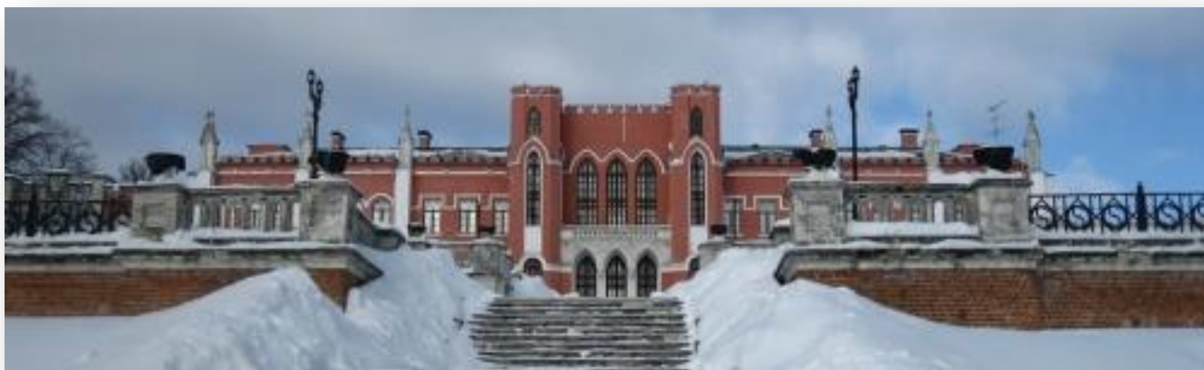
Главный дом в псевдоготическом стиле
