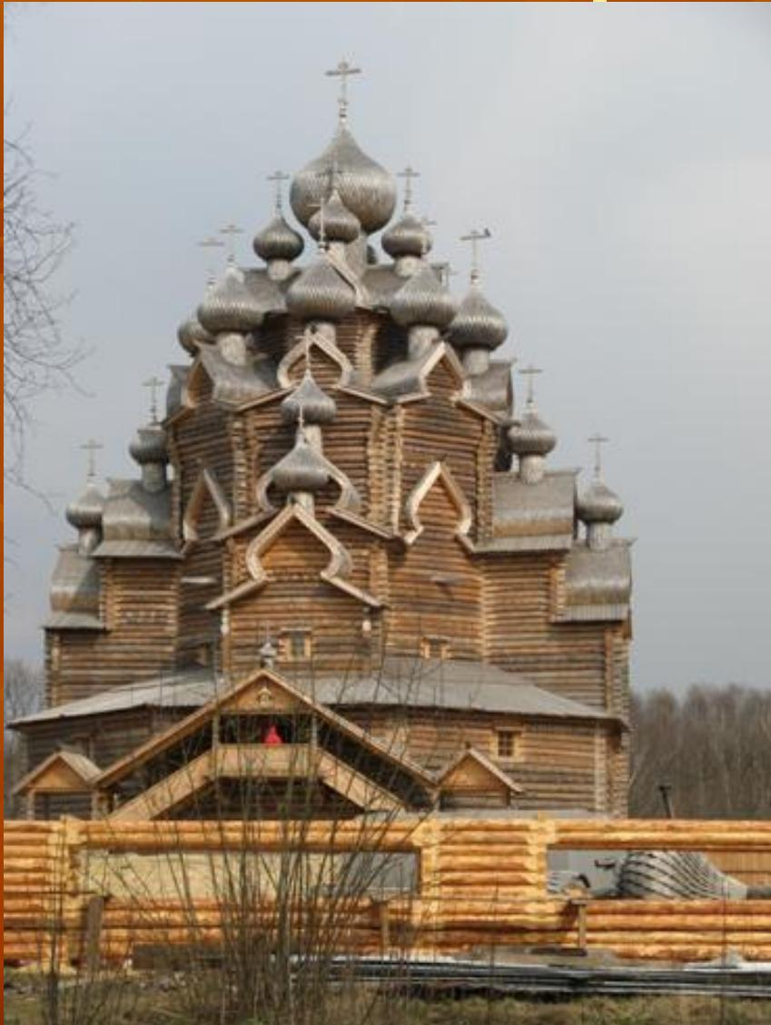
Для определения размеров будущих построек русскими плотницкими дел мастерами была выработана система простых отношений, в основе которой лежала русская система мер, тесно связанная со средними размерами человеческого тела. При использовании системы древнерусских саженей, сооружения приобретают гармоничный и живой характер.
