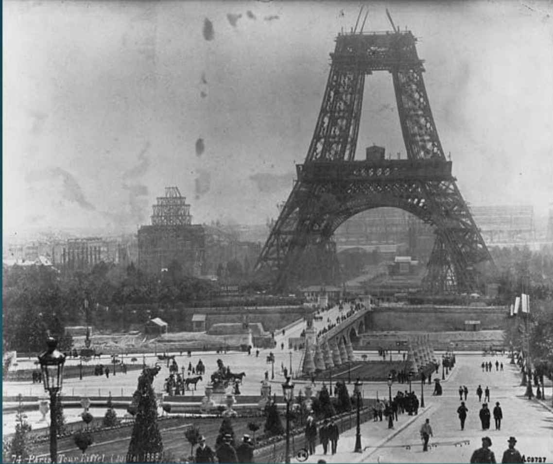
Будівництво вежі, липень 1888
