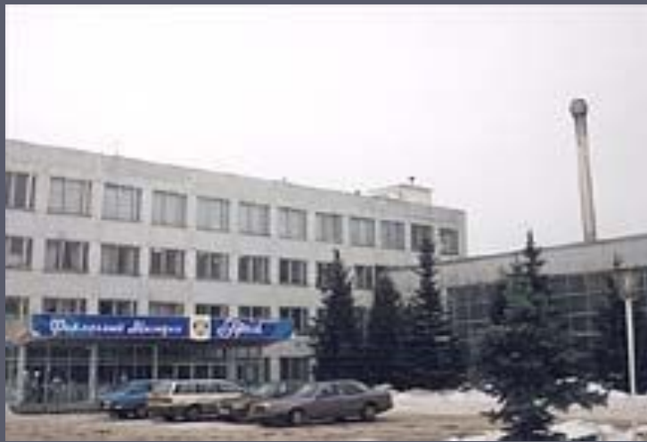
Здание объединения «Гжель»
