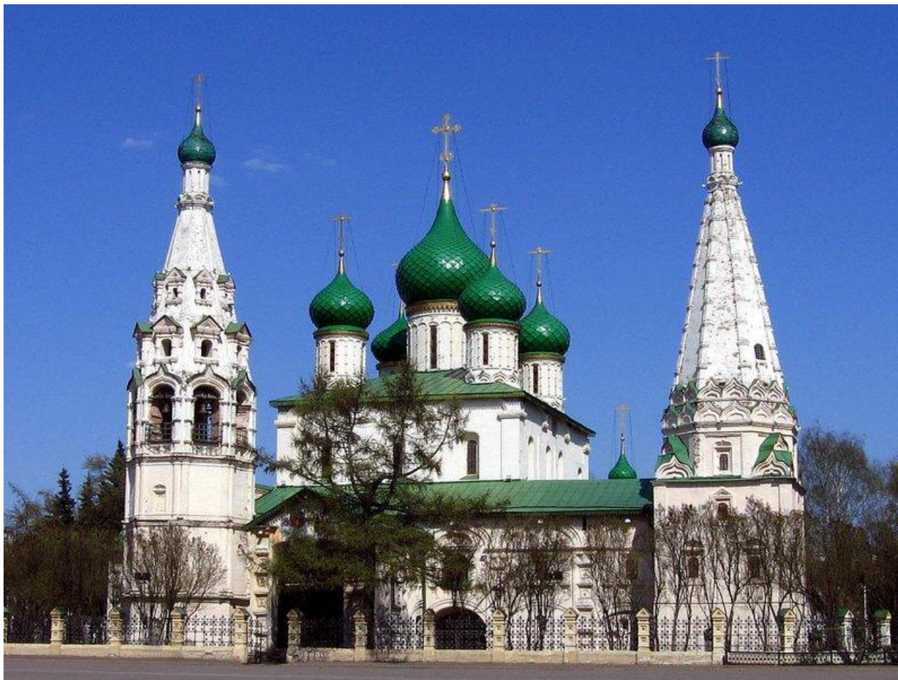
Церковь Ильи Пророка в Ярославле
