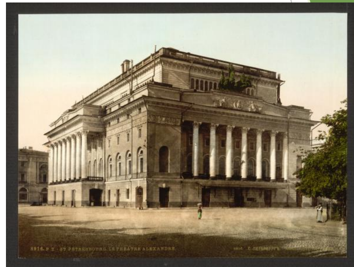
Петербургский Александрейский театр – 1445
