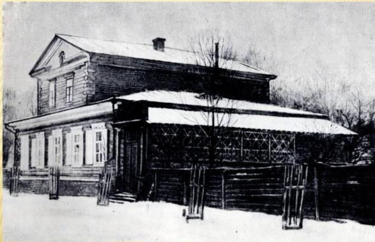
Дом Ушинских в Новгород-Северском
