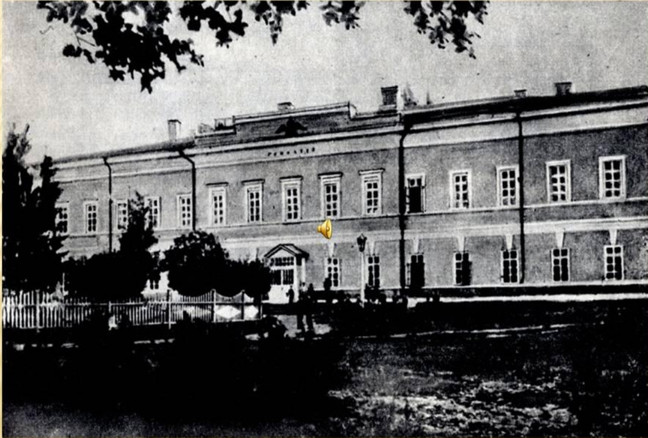
Здание Новгород-Северской гимназии, в которой учился К.Д. Ушинский
