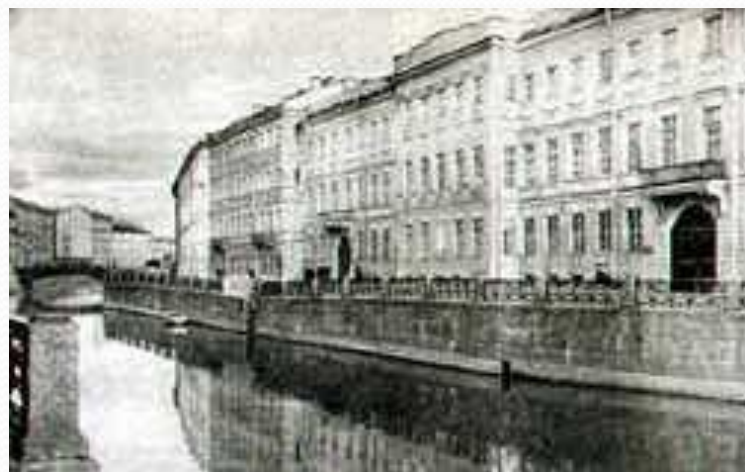
Квартира Пушкина в Петербурге на Набережной Мойки
