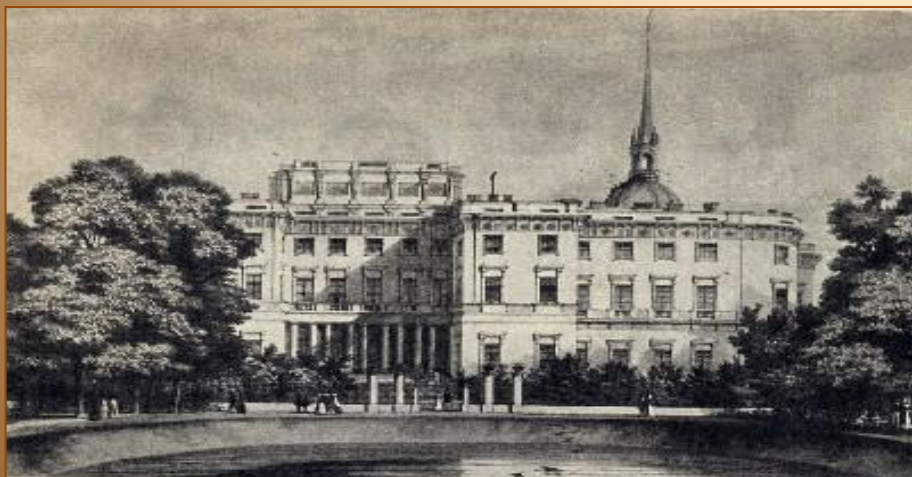
Главное инженерное училище (Инженерный замок)
