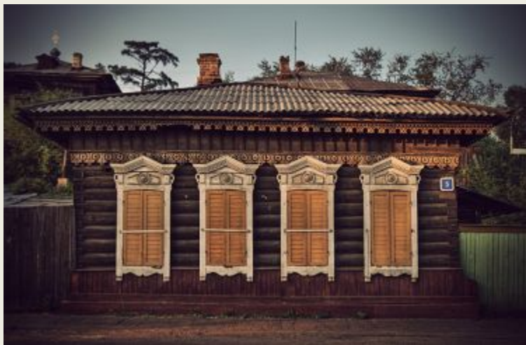
Окна дома закрыты ставнями
