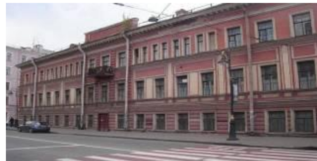
Здание гимназии Ф. Ф. Бычкова (впоследствии Я. Г. Гуревича) в Петербурге. Современный адрес: Лиговский пр-т, 1 / ул. Некрасова, 43.
