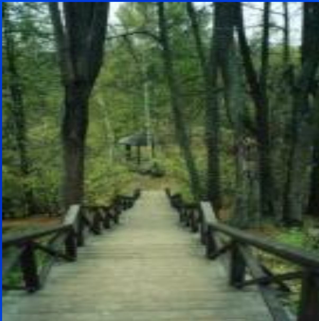
МОСТ ЧЕРЕЗ РЕЧКУ КУЕКШУ
