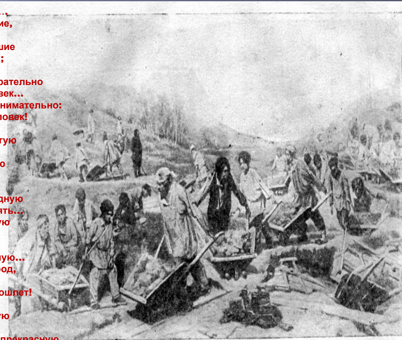
Ремонтные работы на железной дороге. С картины художника К. А. Савицкого,
