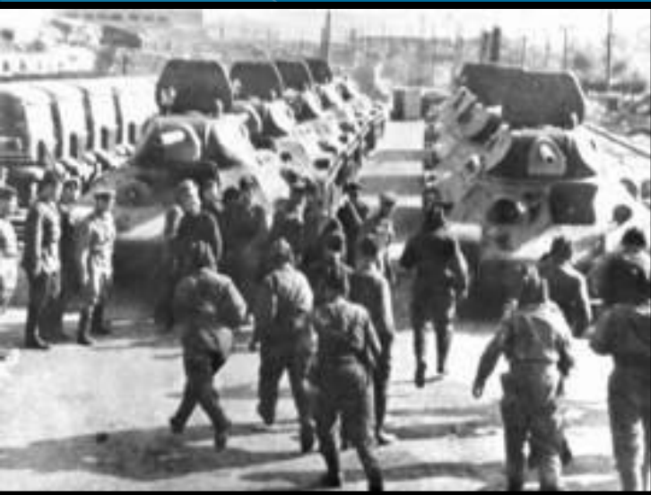
Во дворе Сталинградского тракторного завода
