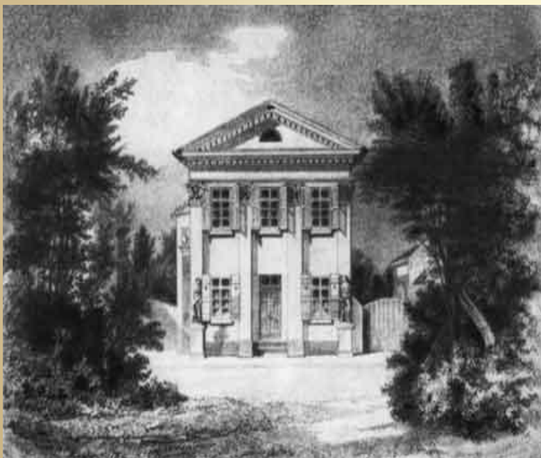
Дом В.А.Жуковского в Дюссельдорфе
