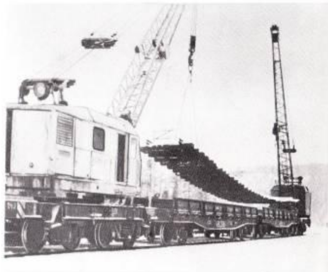
Погрузка готовых звеньев на платформу
