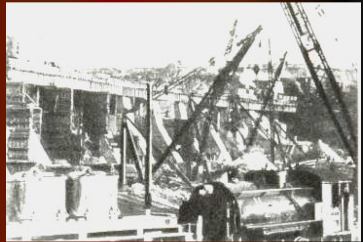
Панорама строительства Днепрогэса.
