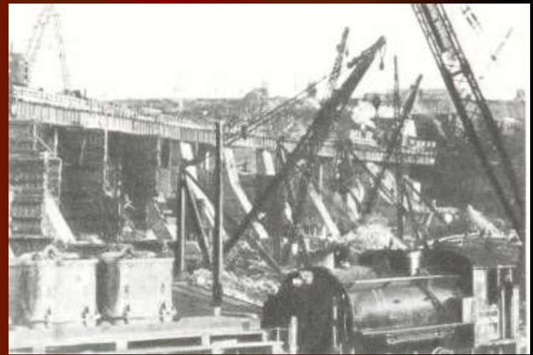
Панорама строительства Днепрогэса.
