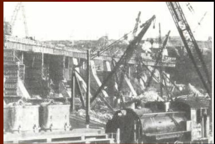
Панорама строительства Днепрогэса.
