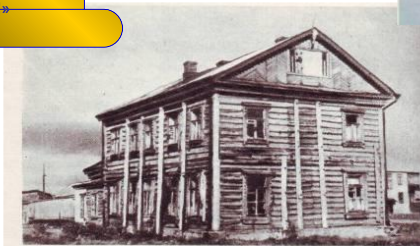
Дом, в котором жила Зоя с 1932 по 1941 год (Александровский пр. Тимирязевского района).
