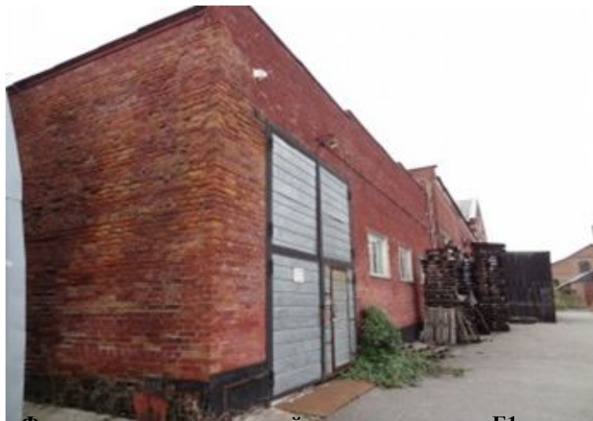
Фото здания склада готовой продукции, литер Б1
