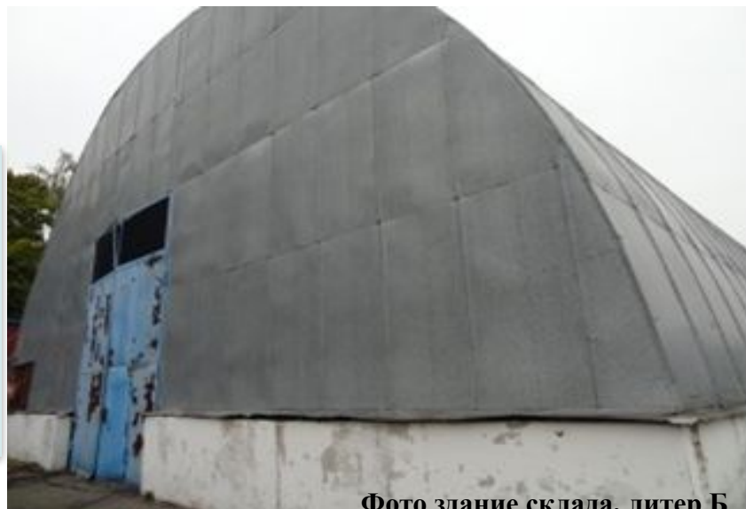
Фото здание склада, литер Б
