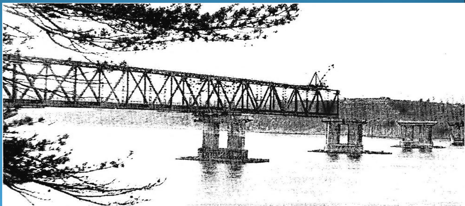
Монтаж металлических болтосварных пролетных строений железнодорожного моста через Ангару в Усть-Илимске (Восточно-Сибирская дорога)
