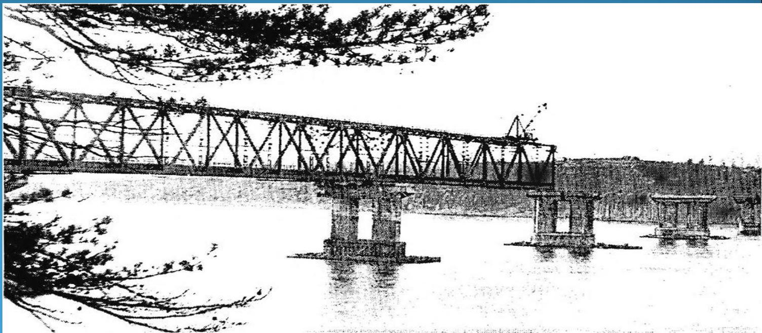
Монтаж металлических болтосварных пролетных строений железнодорожного моста через Ангару в Усть-Илимске (Восточно-Сибирская дорога)
