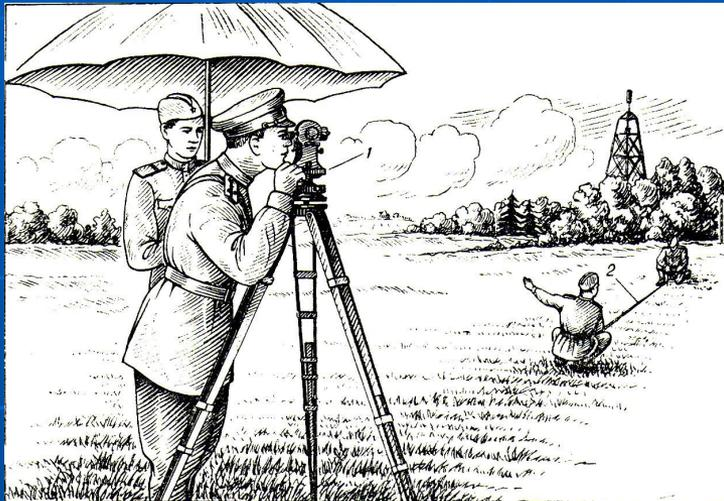
Рис. 5. Измерения, выполняемые на местности с помощью теодолита и мерной ленты
