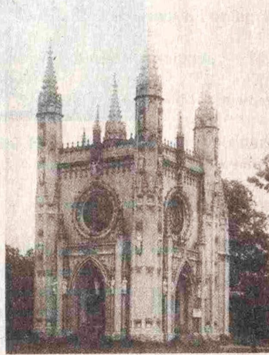
Церковь Александра Невского в Петергофе
