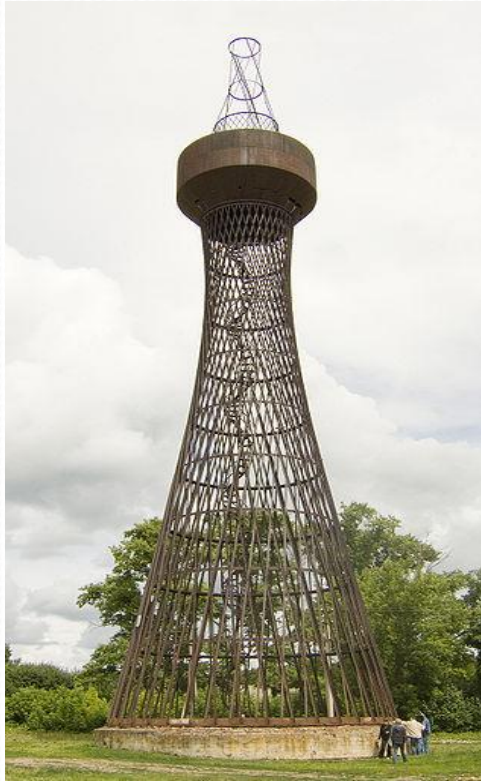
Первая в мире гиперболоидная башня В. Г.Шухова в Полибине (Липецкая область)
