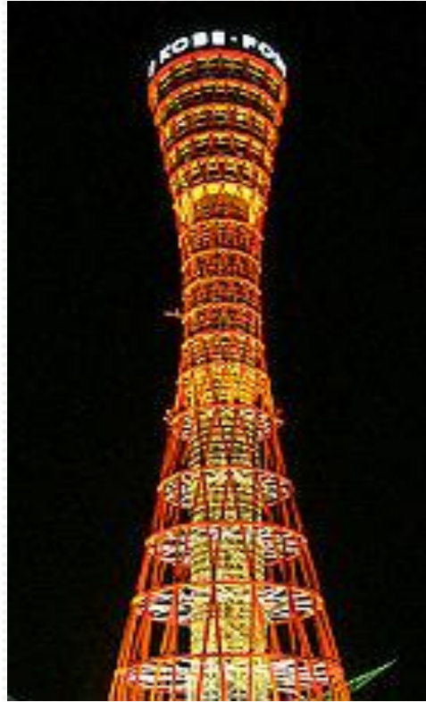
Гиперболоидная башня в порту Кобе (Япония)
