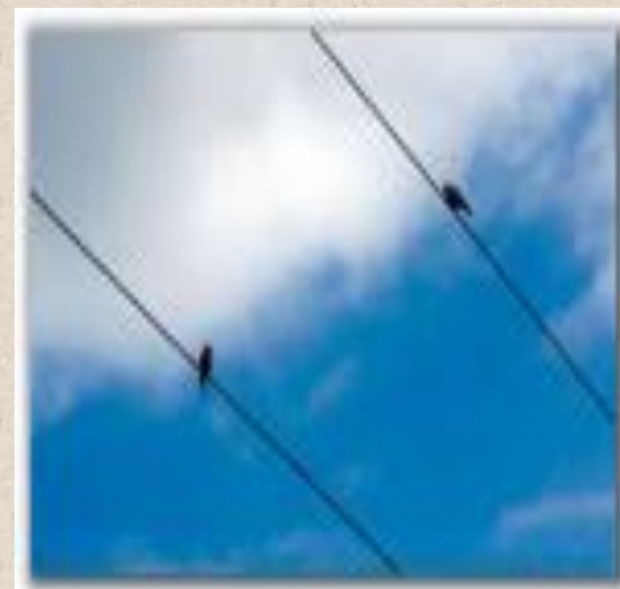
замыкание, нет электричества
