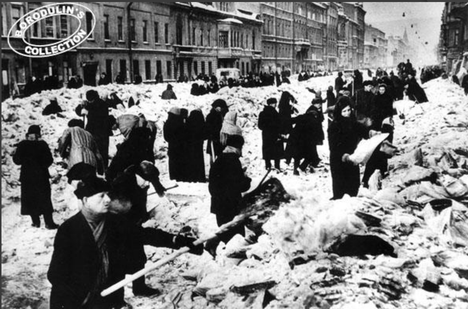
Восстановление Невского проспекта.
