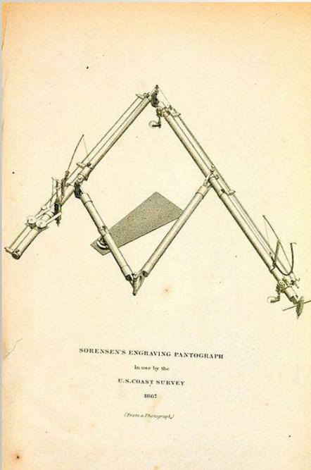
**Панто́граф** — прибор, служащий для перечерчивания планов, карт и т. п. в другом, обычно более мелком масштабе.
