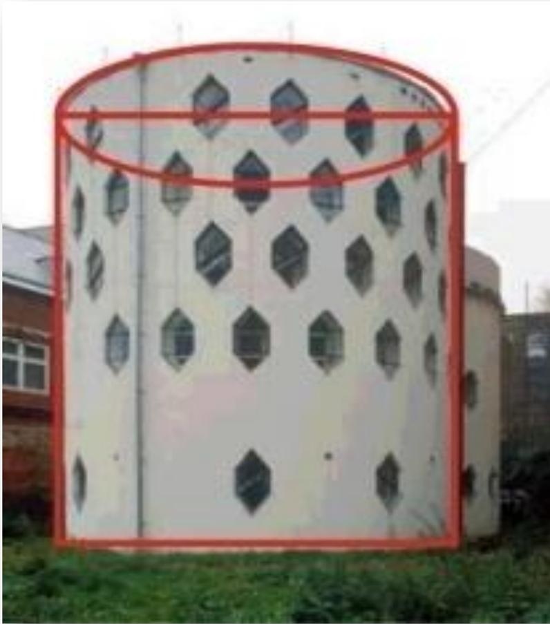
построен в 1927-1929 гг. в Москве по проекту Константина Мельникова. Объёмная композиция дома представляет собой два разновысоких вертикальных цилиндра одинакового диаметра, врезанных друг в друга на треть радиуса, образуя тем самым необычную форму плана в виде цифры «8».
