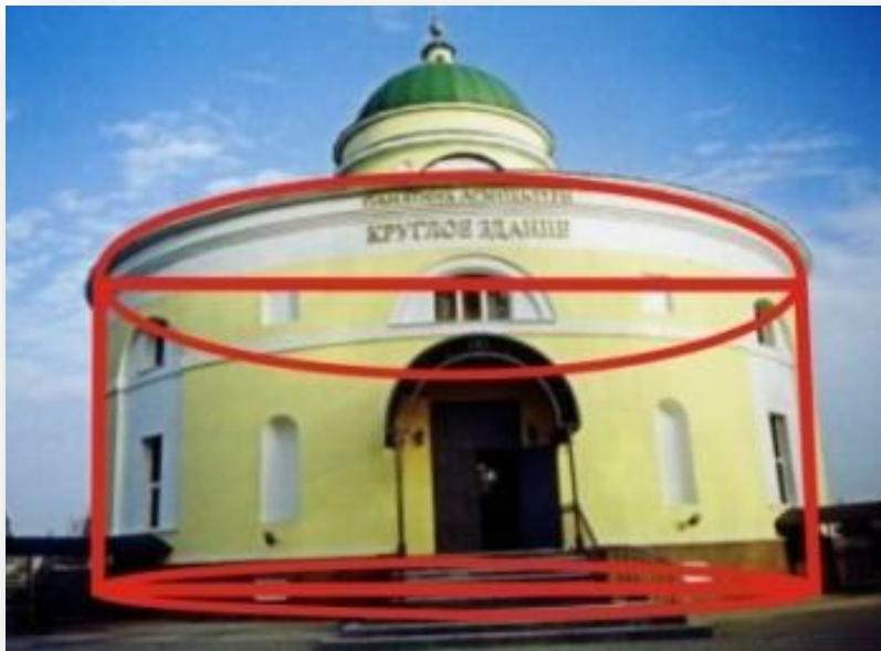
расположено в Белгородской области, было построено в 1790 г. Возведенное из кирпича сооружение состоит из двух цилиндров — большого, диаметром 26 м., и малого внутри него, диаметром ок. 10 м. Внутренний цилиндр возвышается над внешним в виде барабана на 4 м. и завершается куполом.
