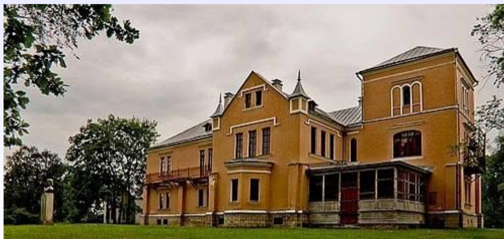
Дом в Палибино после реконструкции
