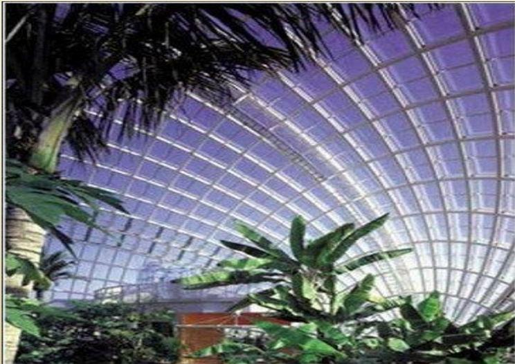
*Как объясняет создатель Музея Плодов в Яманаши Ицуюо Хасегава, одна из немногих преуспевающих японских женщин-архитекторов, "геометрия трех оболочек была проанализирована с помощью объемных компьютерных построений. Каждая форма была образована путем вращения простых геометрических тел до получения сложных объемов"*
